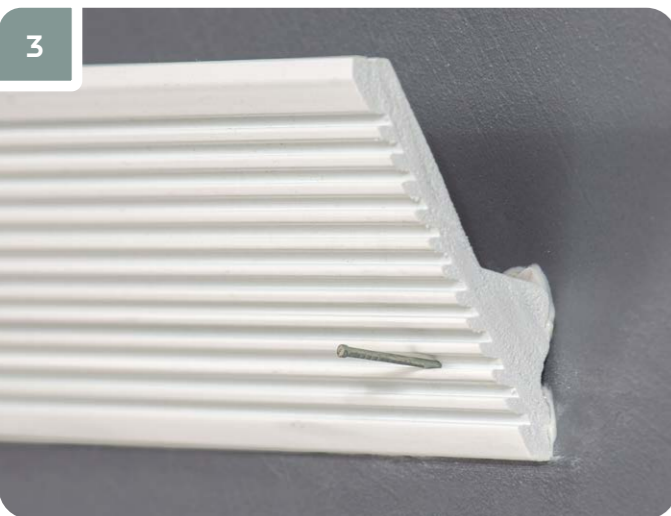
3 Аккуратно зафиксировать изделие финишными гвоздями, не повреждая рисунок орнамента (в данном случае финишный гвоздь размещен в пазу). На одно изделие нужно 3 финишных гвоздя.
