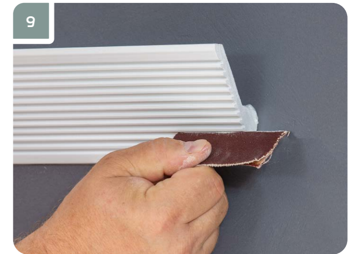
9 Спустя 3 часа мелкозернистой наждачной бумагой обработать зашпаклеванные места.
