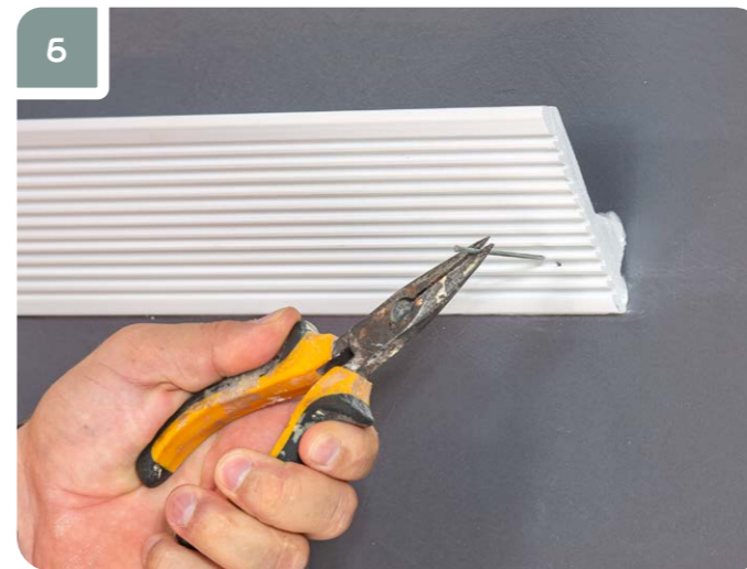
6 Удалить финишные гвозди спустя 24 часа.
