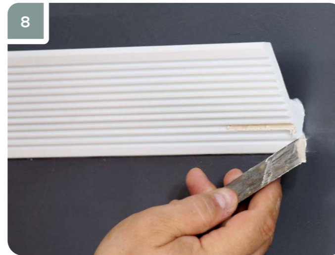
8 Зашпаклевать оставшееся после удаления финишного гвоздя отверстие с помощью финишной шпаклевки для внутренних работ.
