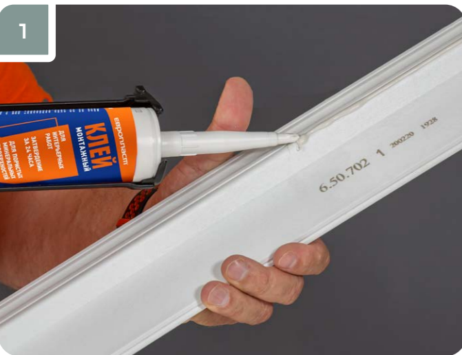
1 Равномерно нанести на монтажную поверхность клей по всей длине изделия.
