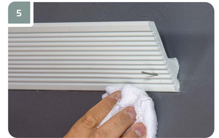
5 Удалить излишки клея ветошью, смоченной водой — при использовании клея «Европласт Монтажный», ацетоном — при использовании клея «Европласт Универсальный».
