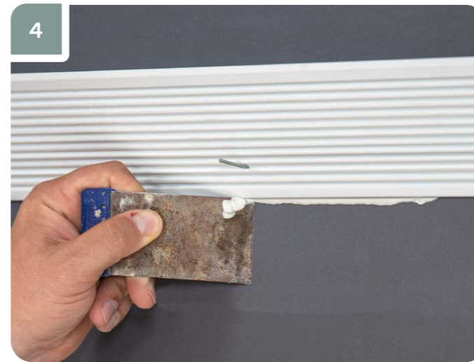
4 Удалить выступившие излишки клея шпателем.
